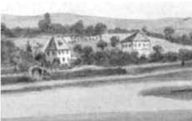
Auf dem Stich von 1776 (Auszug, vor der Gestaltung der Parklandschaft) ist rechts neben Goethes Gartenhaus in Weimar das sogenannte Pogwisch-Haus gut zu erkennen. Es soll künftig als Gästehaus dienen.
